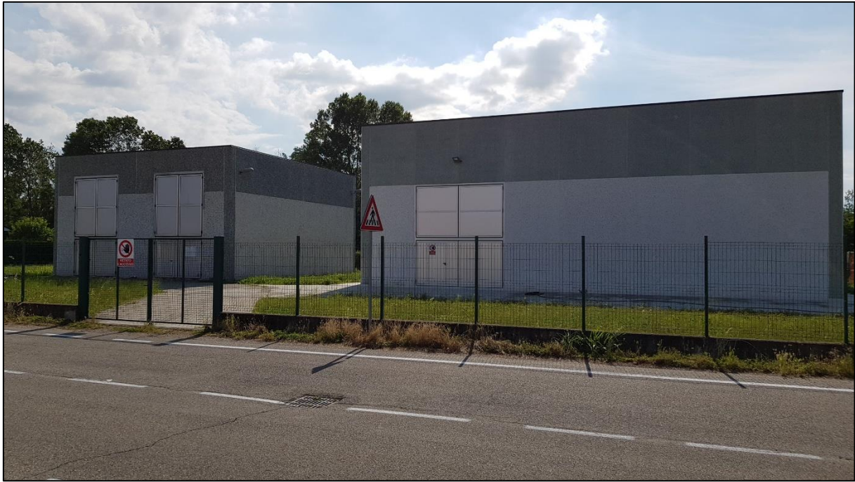
Fig.6: Vista del polo acquedottistico di Via d'Antona (a sx edificio trattamento, a dx vasca di accumulo)
