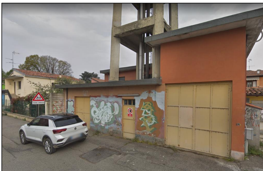
Fig.4: Ingresso principale della centrale di potabilizzazione di Via Giordano Bruno
